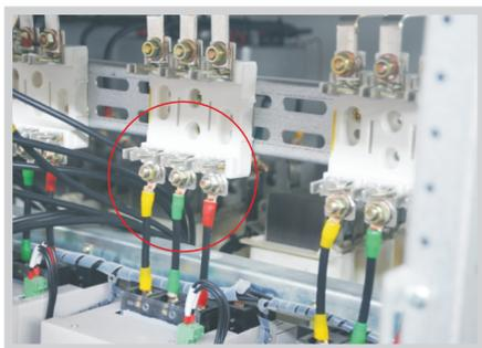
Используйте подходящие кабельные наконечники для надежного подключения. Избегайте повреждения наконечника
